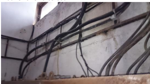
Suterén bazénu – pronikání vody z bazénového tělesa
