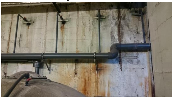
Suterén bazénu – pronikání vody z bazénového tělesa
