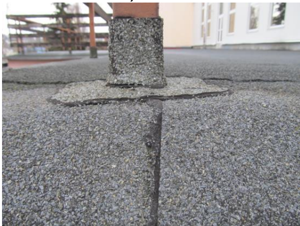
Detail hydroizolace terasy – vyhovující stav
