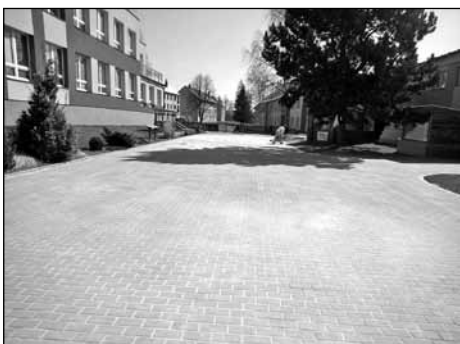
Po dokončení dlážděné plochy uvnitř areálu základní školy.
