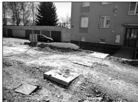
Jedna ze tří plynových přípojek, na které bude provedena překládka. Bude uložena níže do budoucí komunikace.
