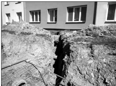
Výkop pro vodovodní přípojku.
