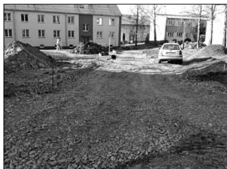
Příprava konstrukčních vrstev pro příjezdovou komunikaci do areálu ZŠ pohled z ulice Nerudova.
