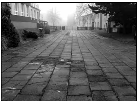
Před opravou dlážděné plochy uvnitř areálu základní školy.
