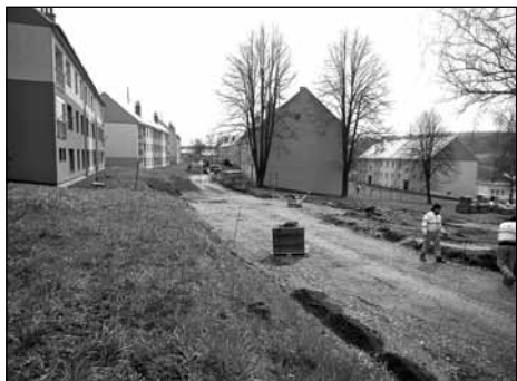
Příprava komunikace, osazování silničních obrubníků.
